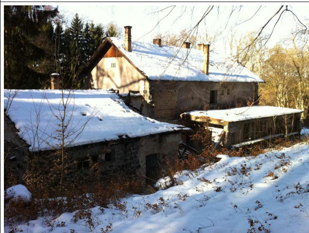
Fotó – toldott épületszárny keletről
