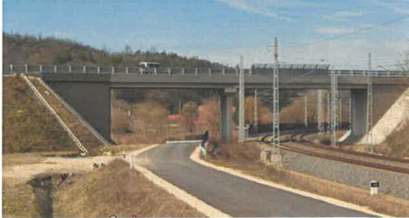
A 80 jelű vasúti pálya és a 3103 jelű összekötőút külön szintű kereszteződése
