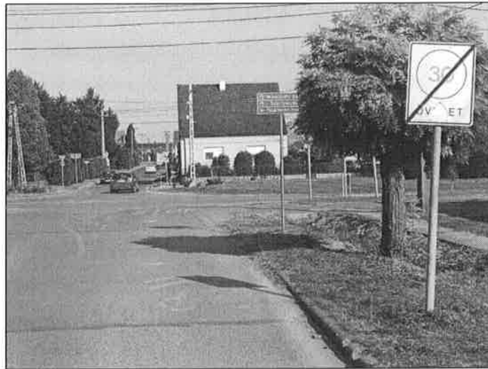
5. sz. fénykép: A József A. utca Pécsi úti csatlakozásában nem megfelelően észlelhető „STOP” tábla
