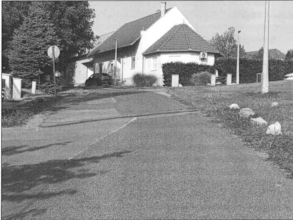
18. sz. fénykép: A Jácint utca csatlakozásában egyenrangú útkereszteződés és a Viola u. felől jelentős emelkedőn érkező alárendelt irány
