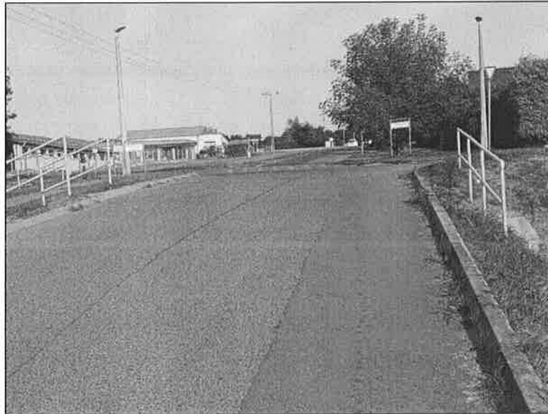
9. sz. fénykép: A Liliom utca és a Viola utca csatlakozásában lévő, nem megfelelően észlelhető burkolatmagasítás
