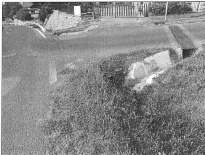
12. sz. fénykép: A Rákóczi utca Kossuth L. utca felől történő jobbra kanyarodó ívének hiányos kialakítása
