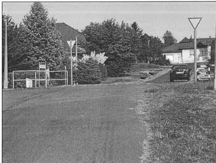
8. sz. fénykép: A Kamilla utca és a Viola utca csatlakozásában lévő, nem megfelelően észlelhető burkolatmagasítás
