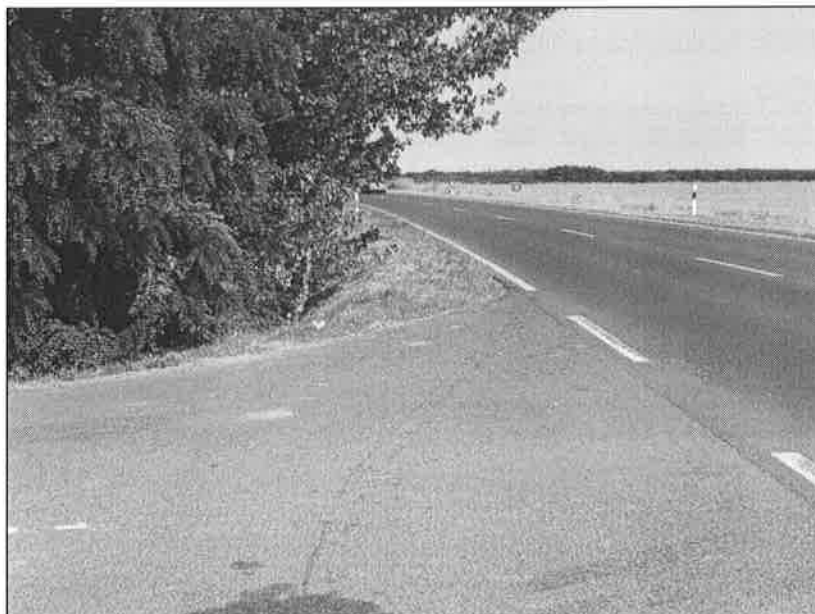
13. sz. fénykép: Az M60 autópálya alatt átvezető út 5711. j. országos közúti csatlakozásában erősen korlátozott rálátás
