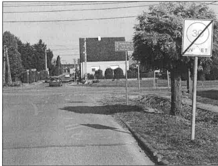
5. sz. fénykép: A József A. utca Pécsi úti csatlakozásában nem megfelelően észlelhető „STOP” tábla
